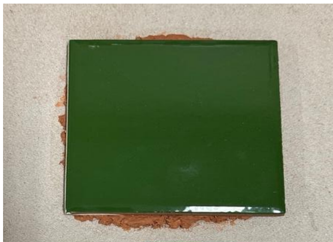
Figura 3 - Aplicação Argamassa Geopolimix no assentamento da lajota.
