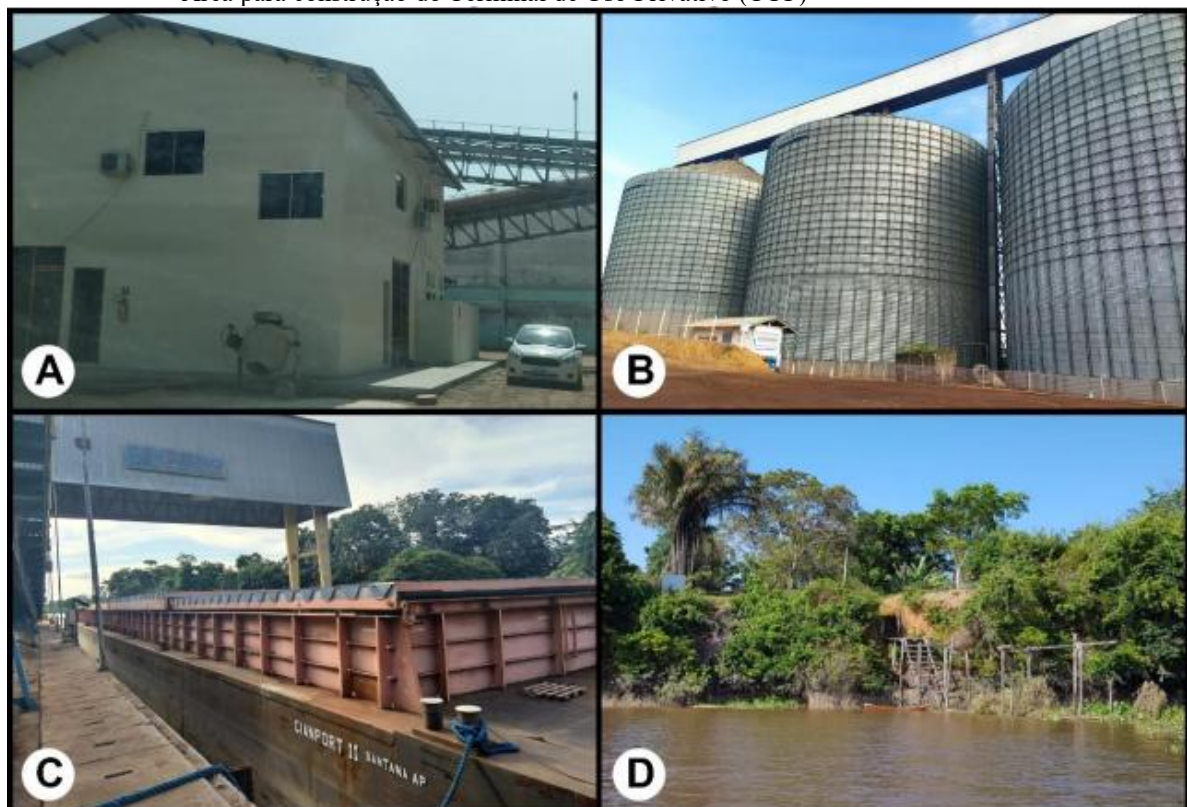
Fotografia 8 - Área da Cianport. A) Prédio administrativo; B) Silos da empresa; C) Barcaças da empresa; e D) Área para construção do Terminal de Uso Privativo (TUP)
